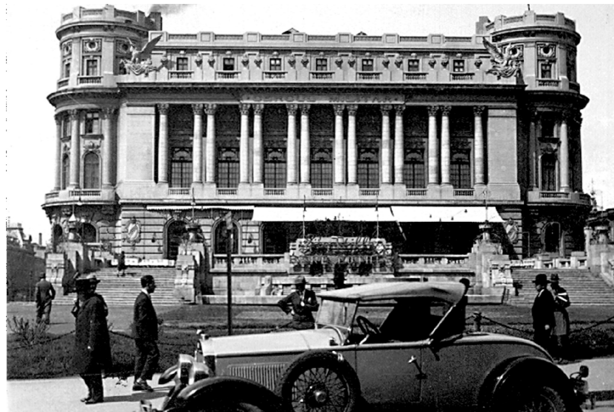
F. 96933. BALUSTRADĂ - Cercul Militar
