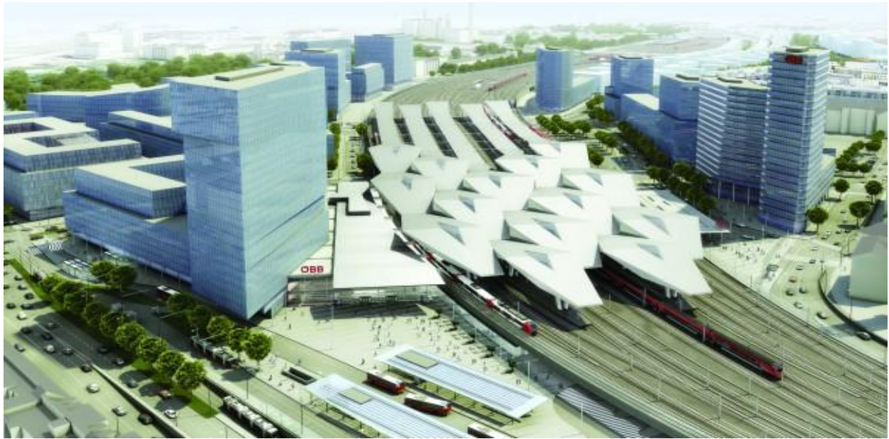
Fig.9-Noua gară principală din Viena și modul de valorificare a terenului disponibilizat!
