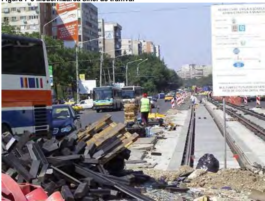
Figura 7-3 Modernizarea sinei de tramvai
