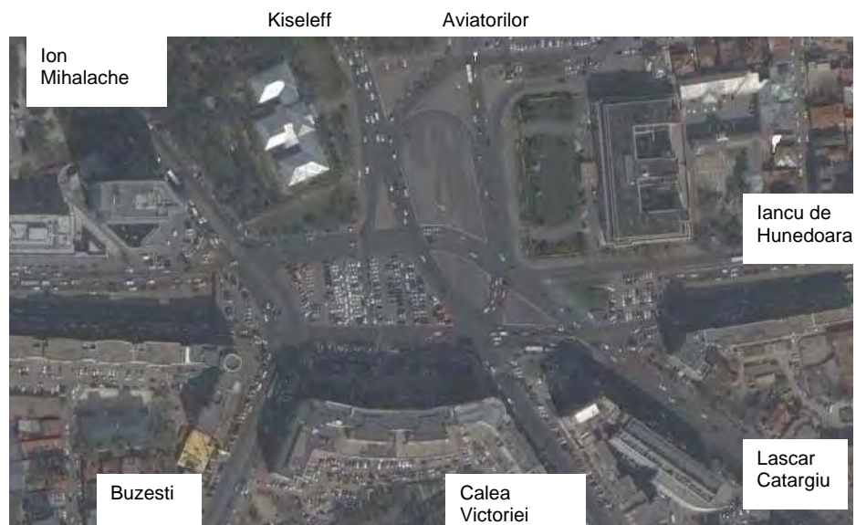
Figura 6-8 Intersecția din Piața Victoriei – Numeroase puncte de conflict și o distanță foarte mare de degajare
