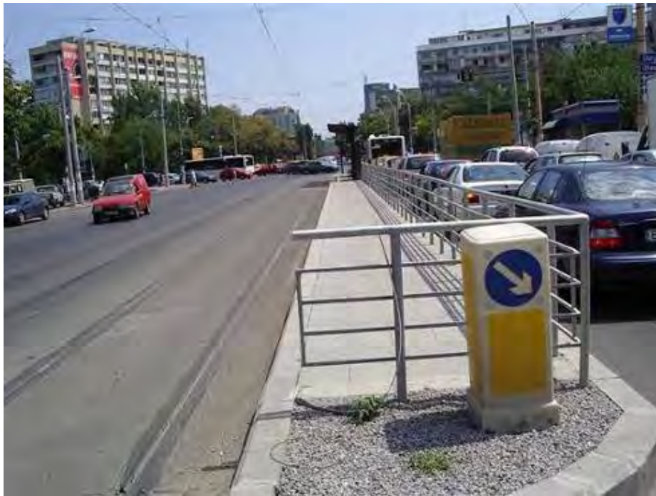
Figura 7-6 Statie si accesul la statie
