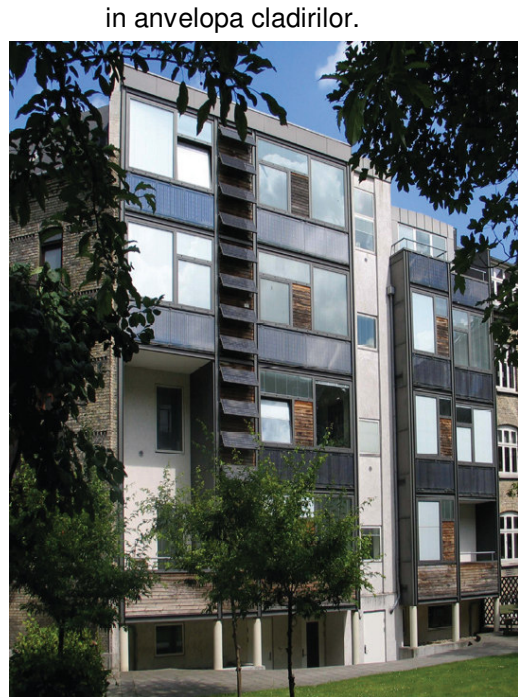
Exemplu de postizolatia a cladirilor construite in 1930, la care integrarea panourilor solare a fost facuta odata cu anveloparea.
