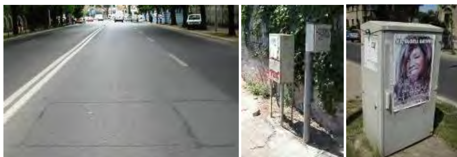
Figura 6-28 București - RATB linia de tramvai 41, detectoarele Peek SPOT UTOPIA, "adaposturi" detectoare și controlori de semnal
