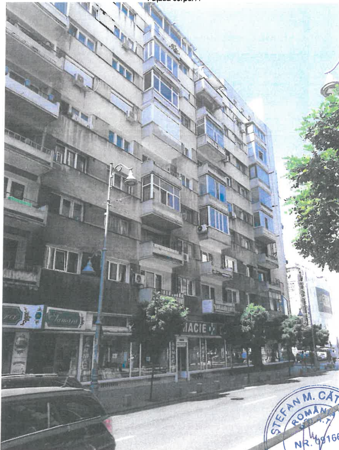
Fațadă corpul A
