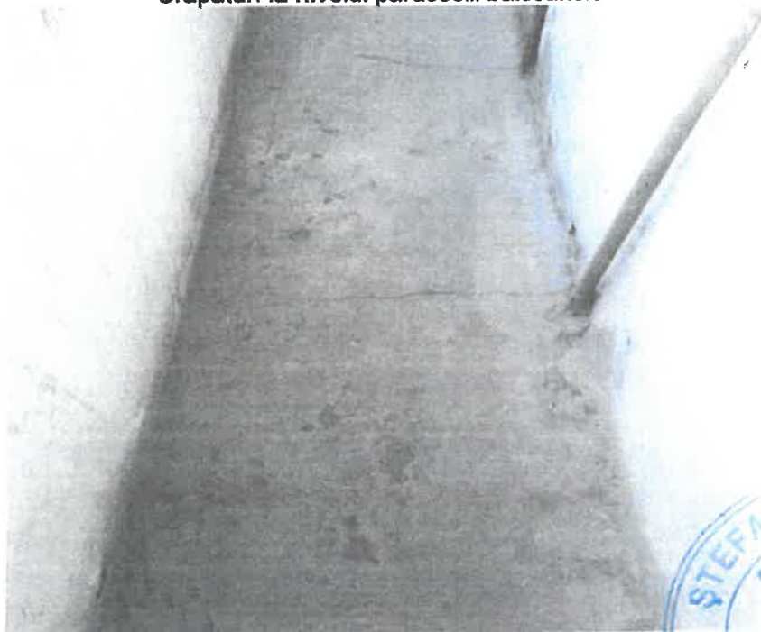
Crăpături ale treptelor scării din interior
