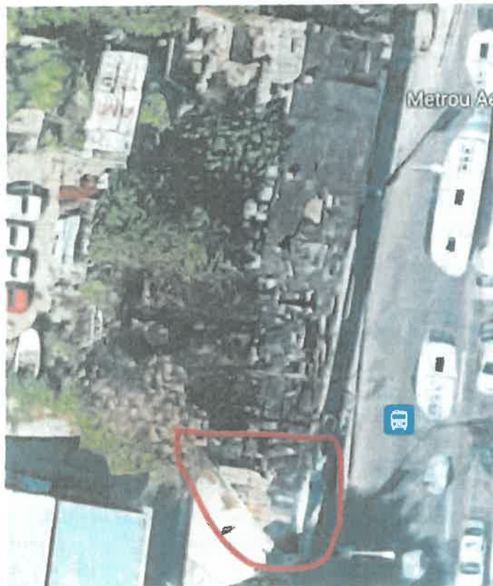
F 11 Starea clădirii amplasate în vecinătatea fațadei de la sud. a clădirii expertizate
