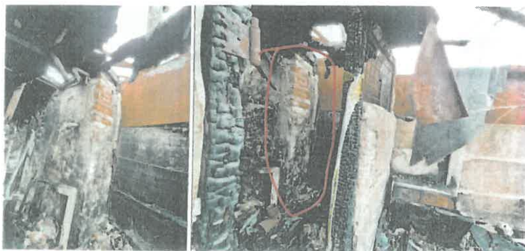
F 8 - Peretele din zidărie al fațadei de la sud și gardul din elemente de beton
