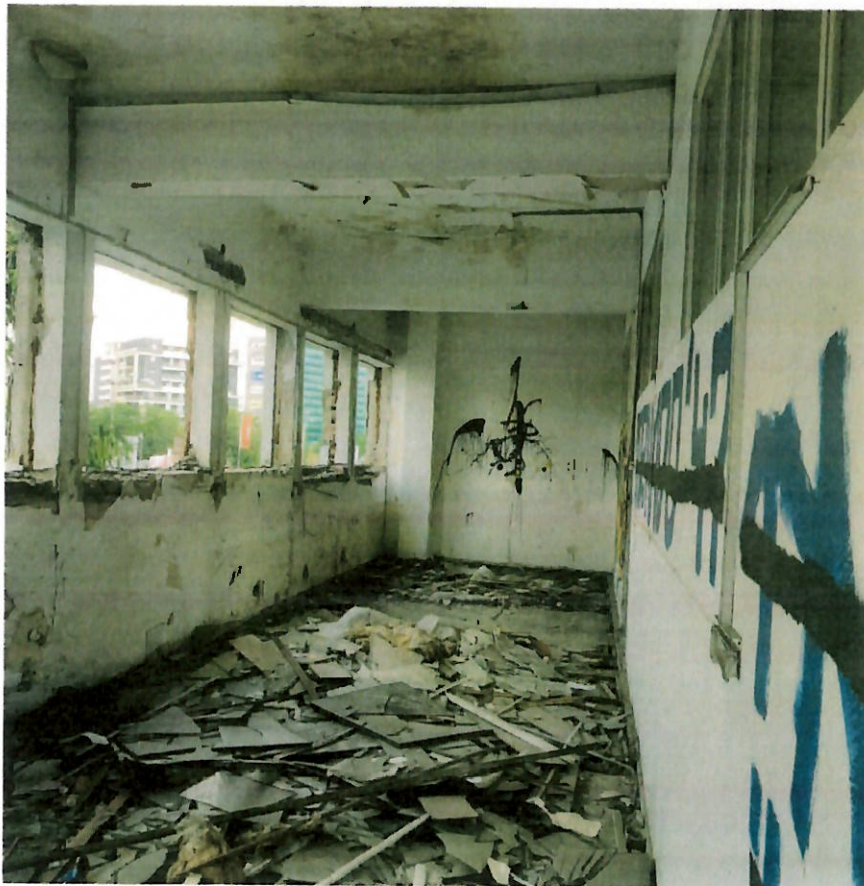
Construcția C1 – Clădire de birouri S+P+M
