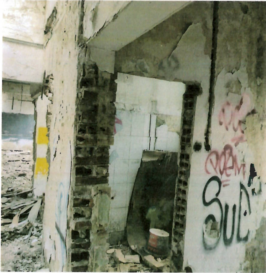
Construcția C1 – Clădire de birouri S+P+M
