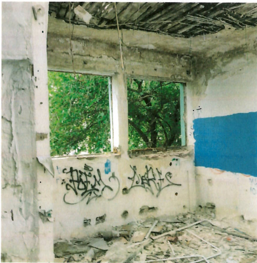
Construcția C1 – Clădire de birouri S+P+M
