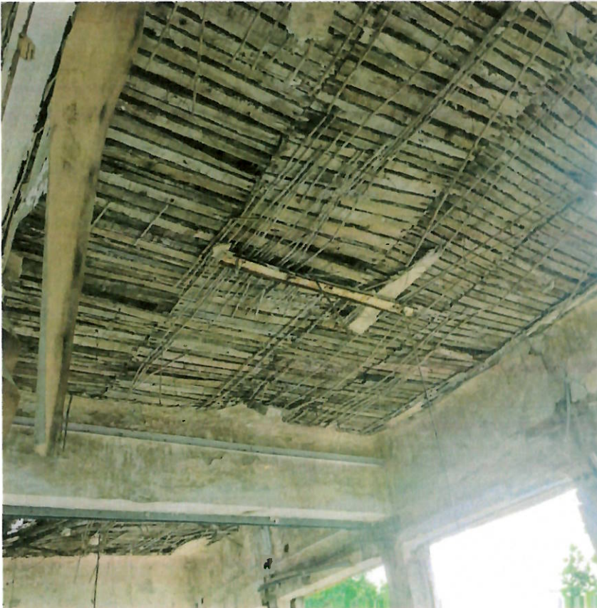
Construcția C1 – Clădire de birouri S+P+M
