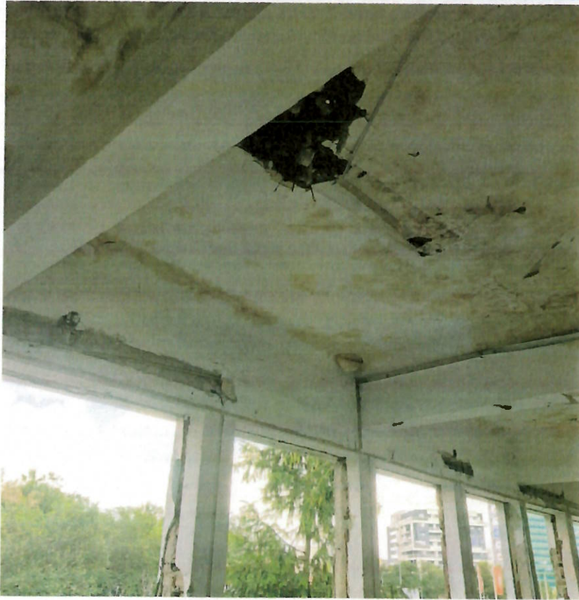
Construcția C1 – Clădire de birouri S+P+M
