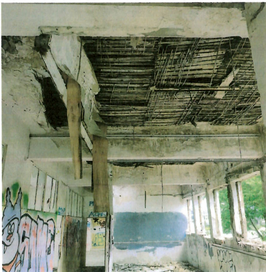
Construcția C1 – Clădire de birouri S+P+M
