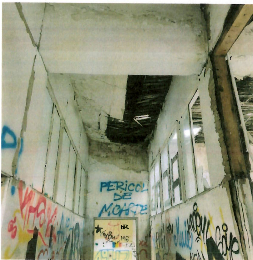
Construcția C1 – Clădire de birouri S+P+M
