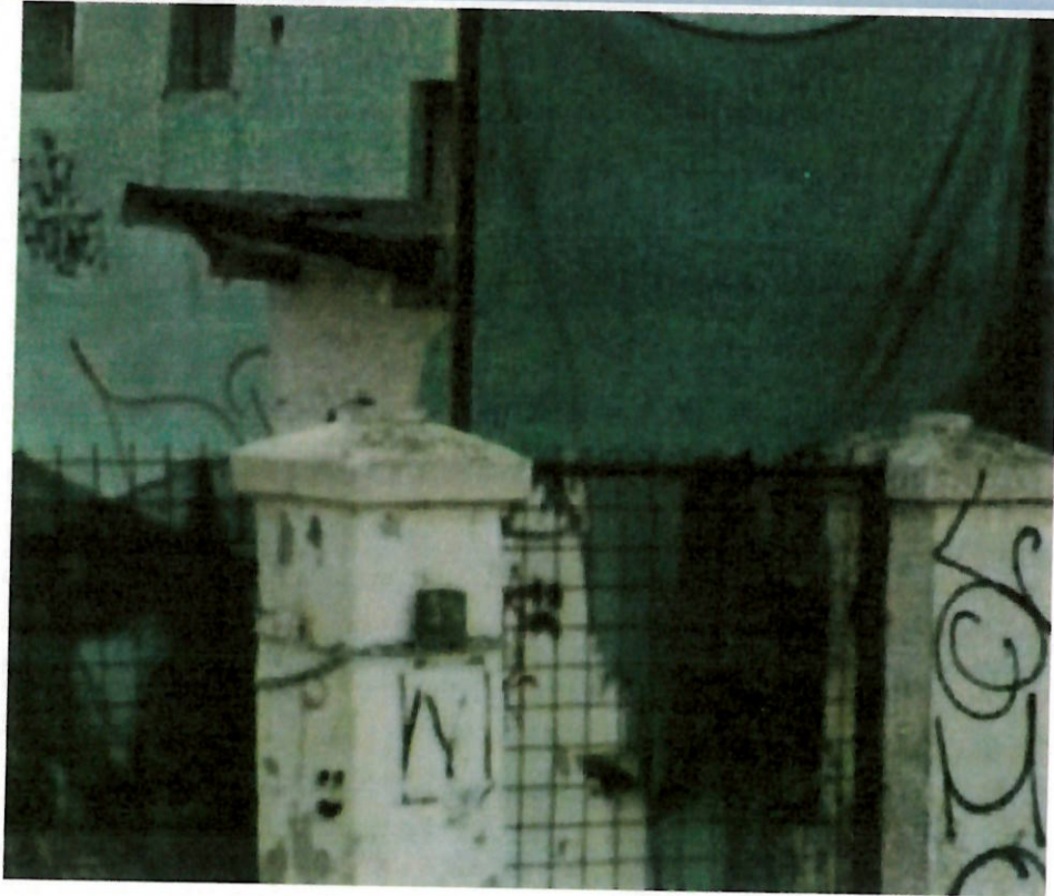
Construcția C4 – Cabina portar P
