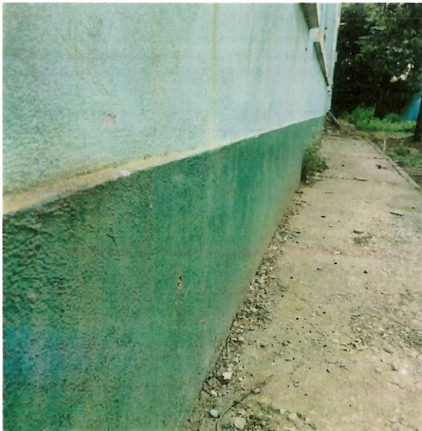
Construcția C1 – Clădire de birouri S+P+M
