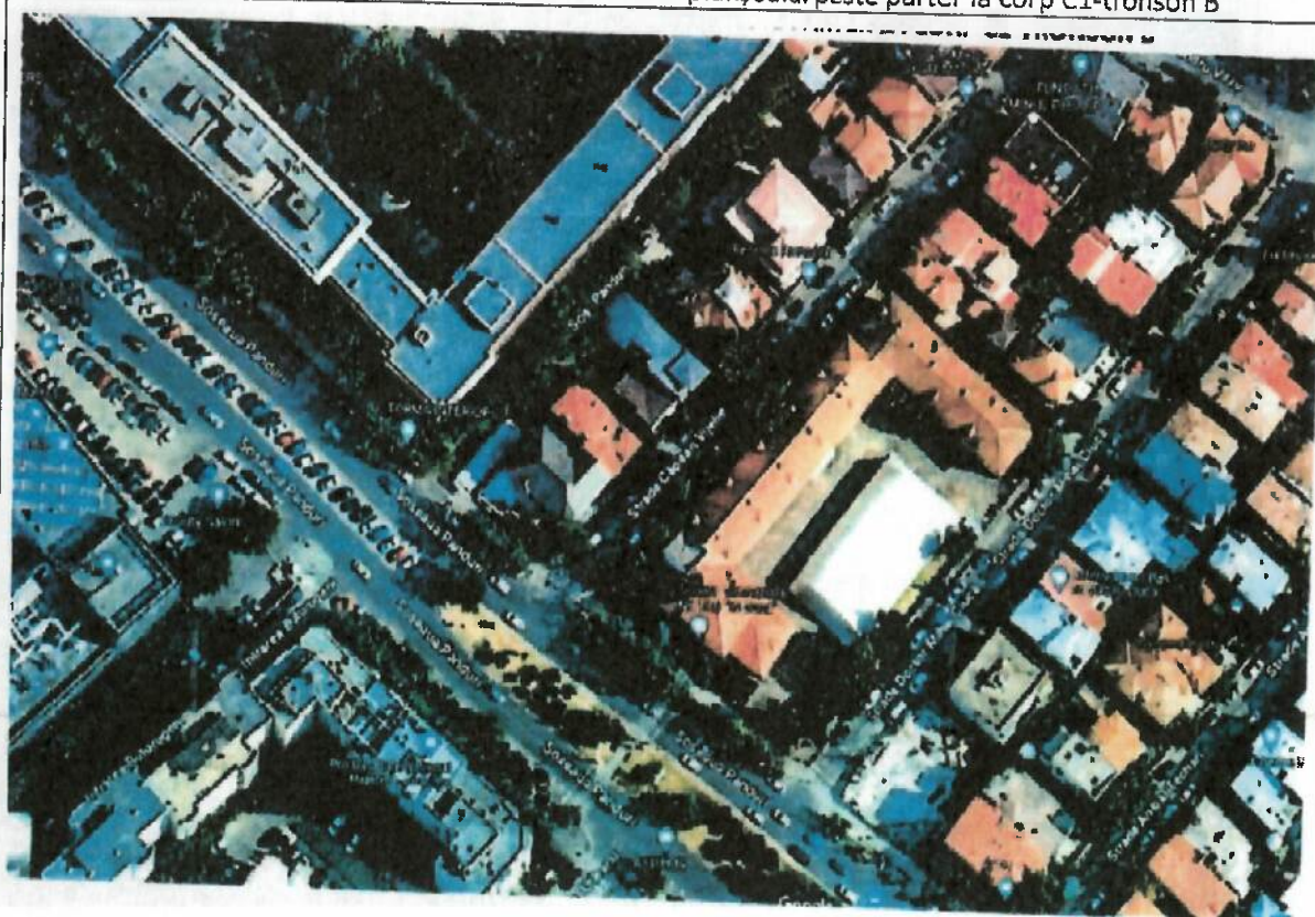
Foto 2 – Situație existentă – vedere aeriană corp C1(tronson A, tronson B), teren sport acoperit cu structura metalică
