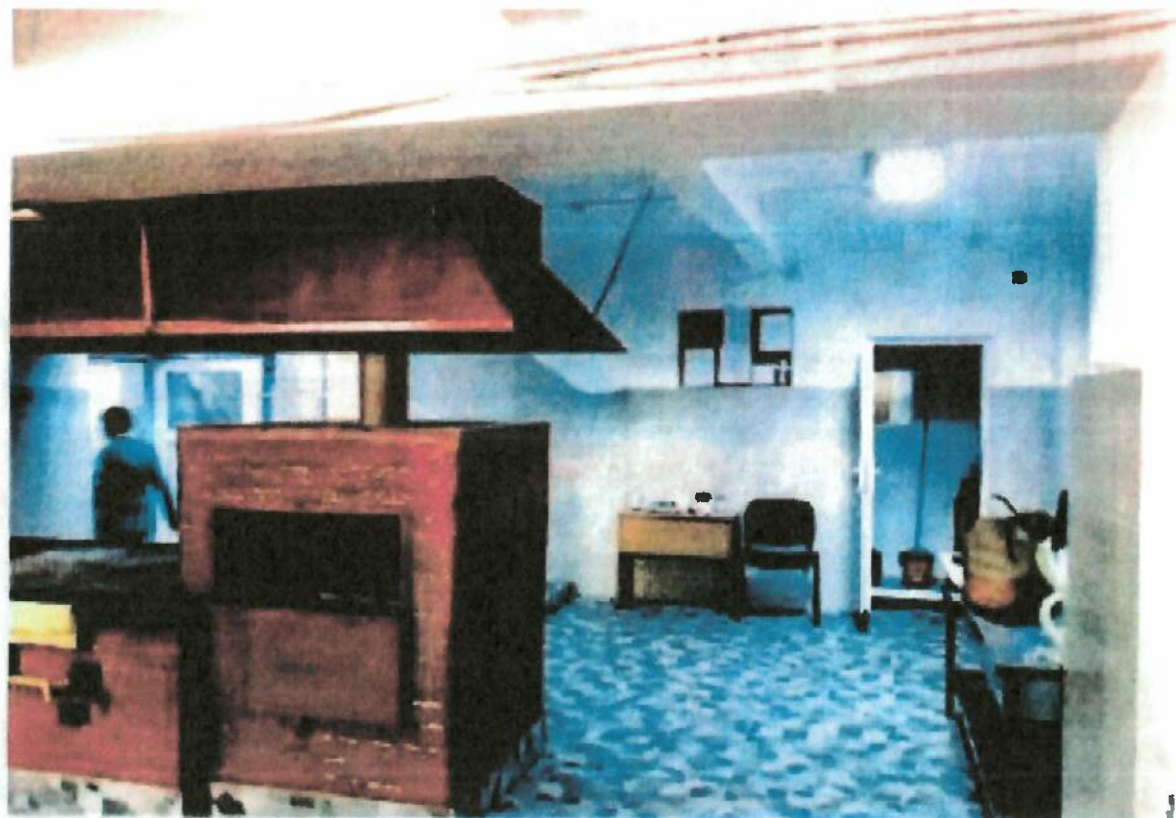
Foto 7 - Situație existentă – Bucătărie subsol corp C1-Tronson A
