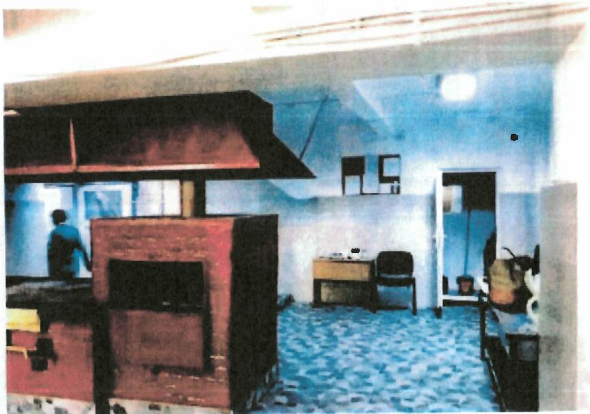
Foto 7 - Situație existentă – Bucătărie subsol corp C1-Tronson A
