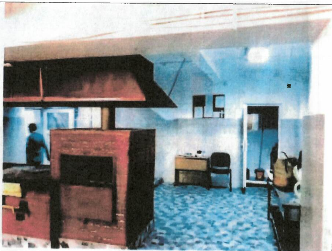
FOTO 7 - Situație existentă – Bucătărie subsol corp C1-Tronson A
