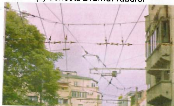
(f) Traversă, consolă și macaz Str. Occidentului
