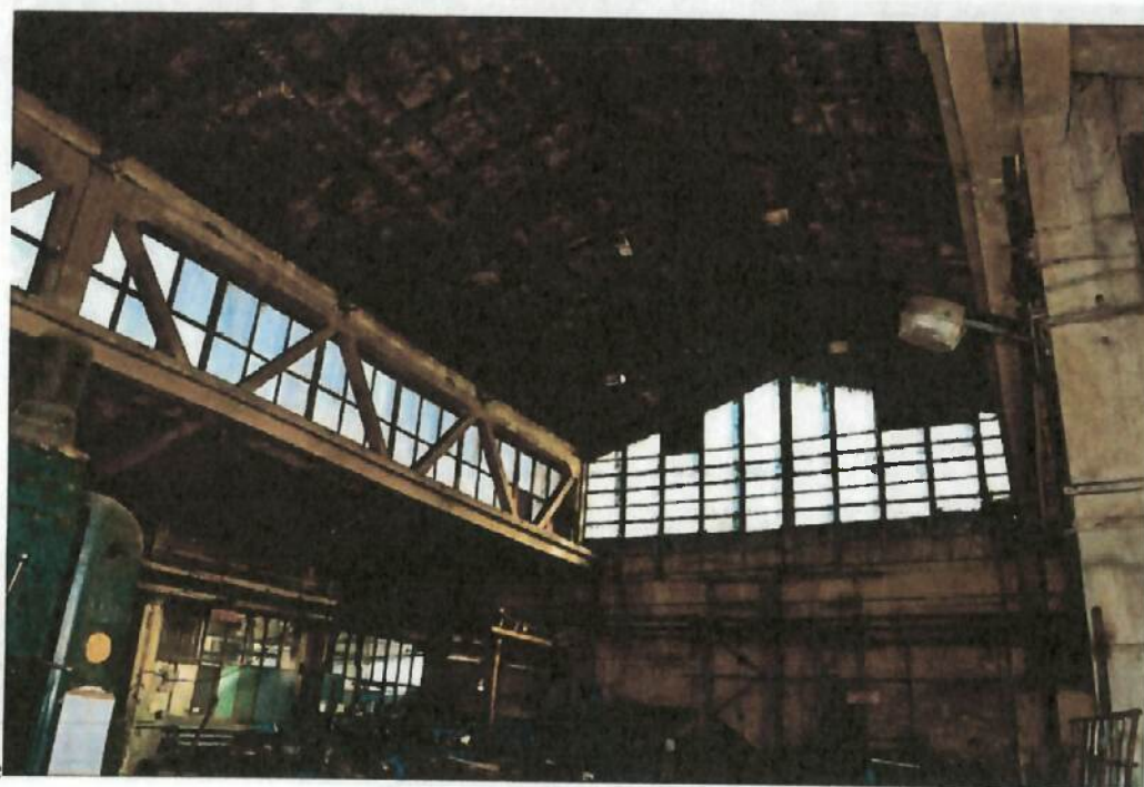
Fig. 2 C28- Atelier intretinere 11, Atelier turnatorie (C28): Luminator central și chesoane din beton armat
