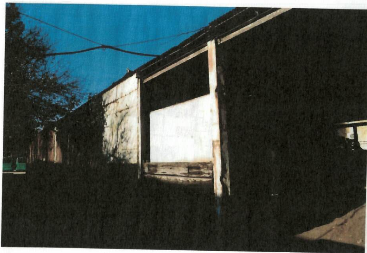
Fig.7 Șopron (C29): Alcătuire structurală improvizată
