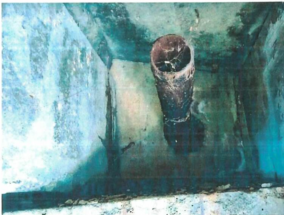
Foto 17: Conducta dezafectata sub trotuar
