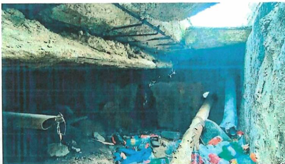
Foto 18: Conducte si instalatii vizibile sub trotuarul aval degradat pe zona culeii insula
