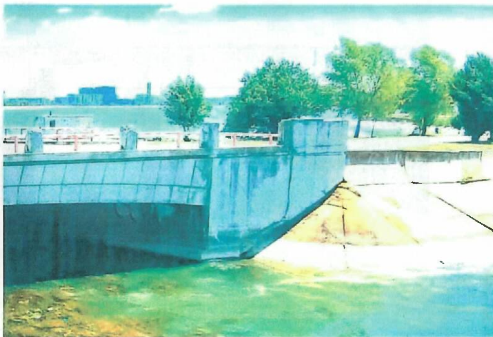
Racordare cu terasamentele culee insula, amonte
