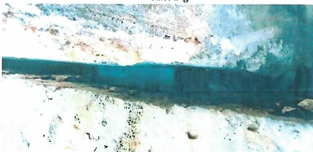
Aparat de reazem din neopren
