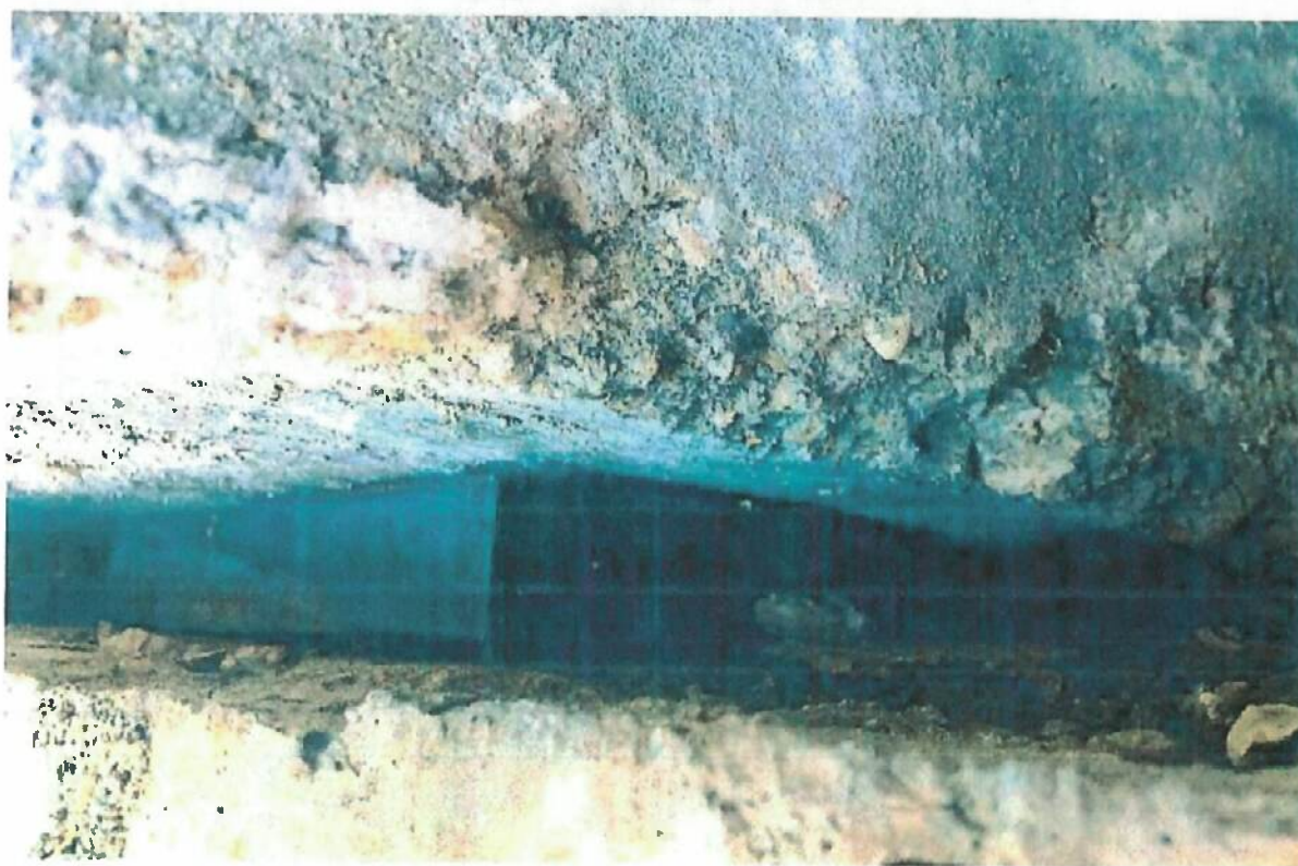
Foto 16: Aparat de reazem din neopren la rezemarea fasiilor
