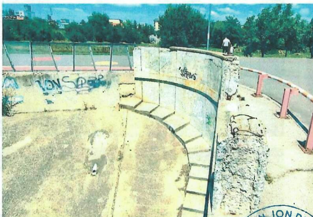
Racordare cu terasamentele culee dig, amonte
