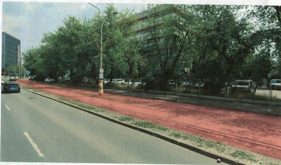
Figură 41 - Starea tehnică degradată a liniilor de tramvai de pe b-dul Dimitrie Pompeiu
