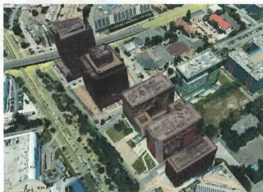
Figură 70 - Construcții de birouri cu P.O.T. scăzut și C.U.T. ridicat situate în partea vestică a Platformei Pipera
