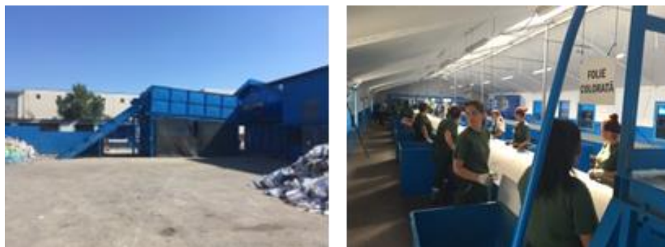
Figura 4-6 Stația de sortare SC URBAN SA
