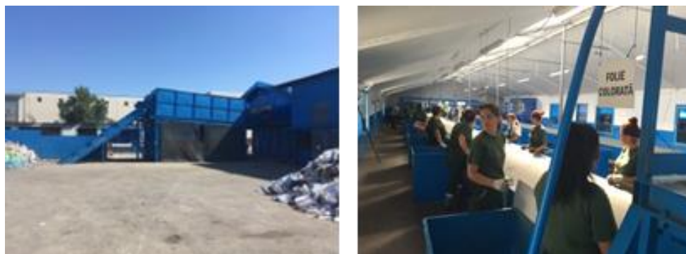
Figura 3-13 Stația de sortare SC URBAN SA
