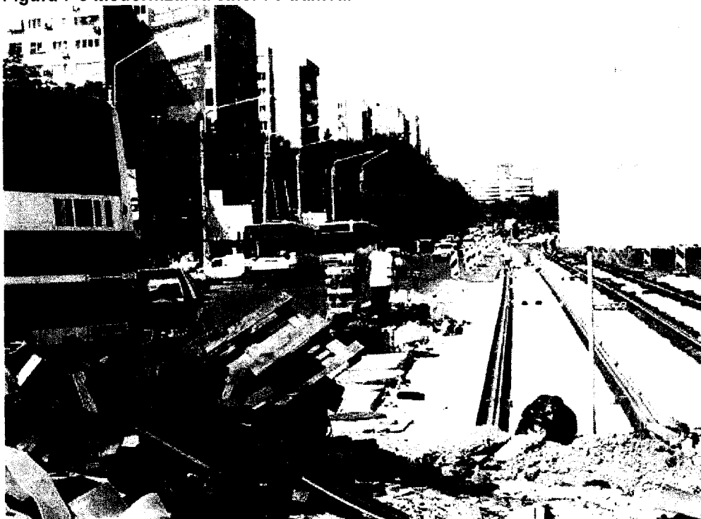
Figura 7-3 Modernizarea sinei de tramvai
