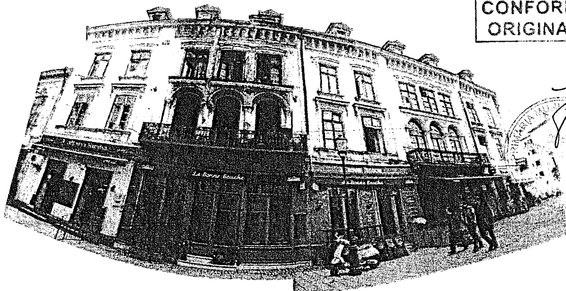
Imagine panoramica Casa Vlasto – anul 2011 (dupa incendiu) FATADA NORD (Str. Franceza nr.30)
