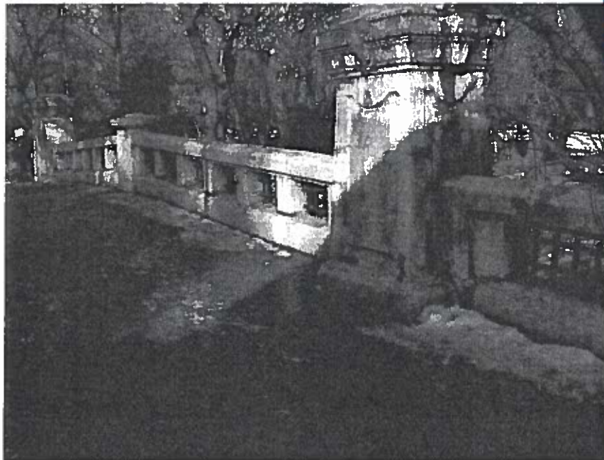
Fotografia 12. Detaliu cale: suprafața imbracamintii incretita in zona stalpului ornamental.
