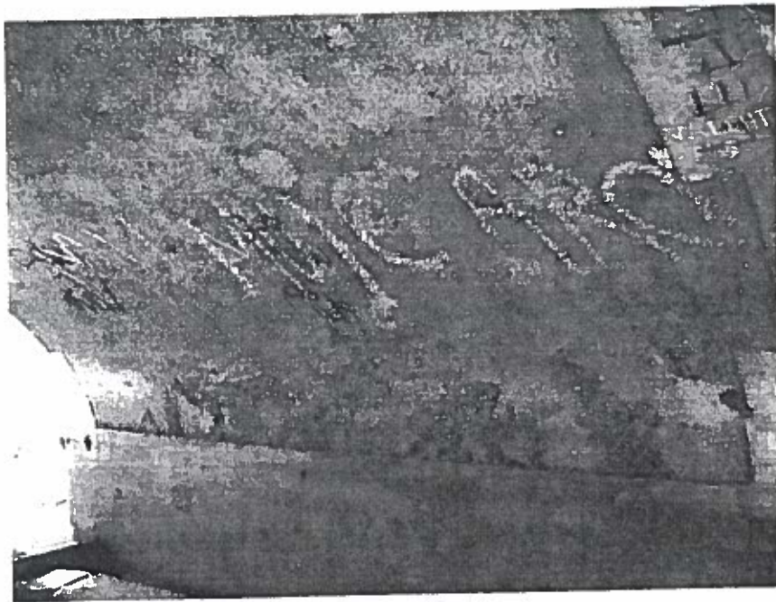
Fotografia 5. Vedere la intradosul boltii la nastere, in zona Aleii Magnoliei: beton segregat, cuiburi de pietris, tencuiala exfoliata.
