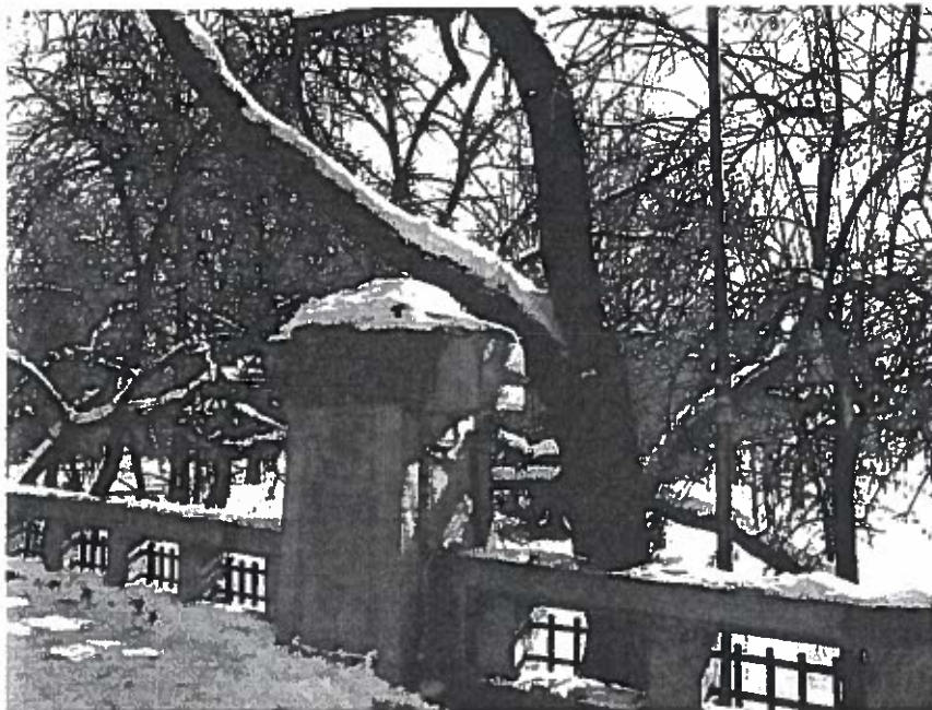
Fotografia 10. Detaliu stalp ornamental : crapatura intre stalpul si panoul de parapet, consola din beton adaugata ulterior pe stalp, total inestetica.
