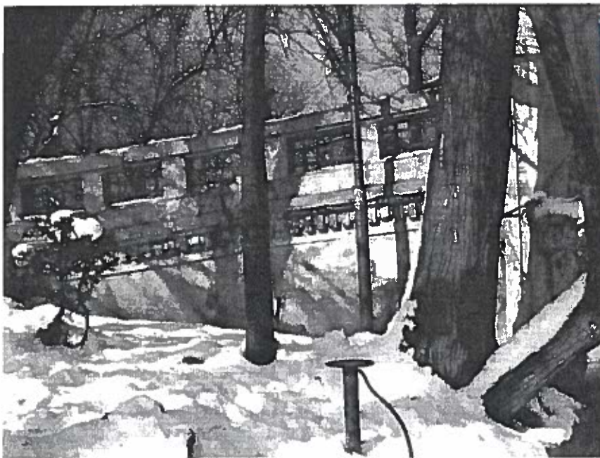
Fotografia 8. Vedere zid intors in zona Aleii Magnoliei, spre debarcader: infiltratii in zid si crapaturi in zid si parapet.
