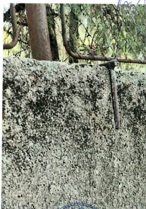
Zona gard expulzata - armatura panourilor de placare expusa cu deteriorarea elementului betonat
