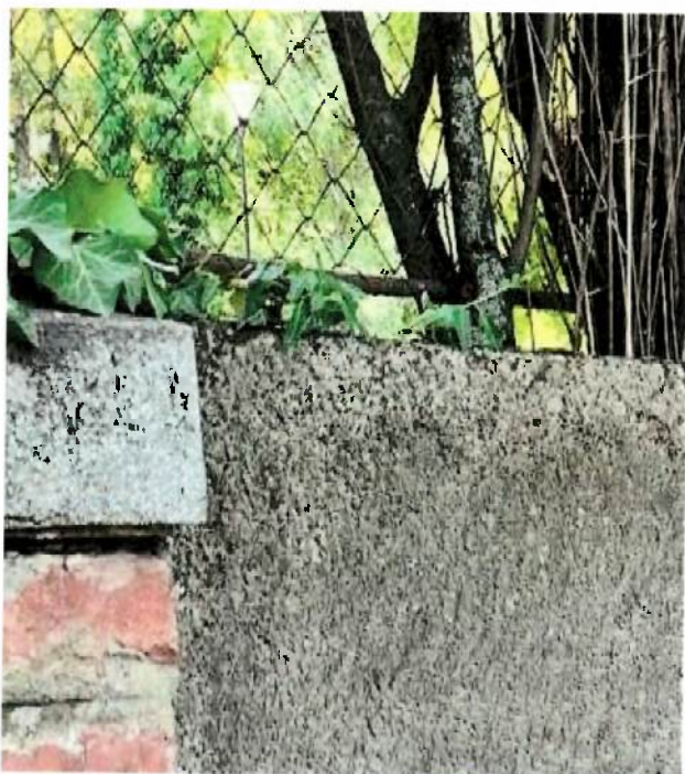
Zona gard expulzata - armatura panourilor de placare expusa cu deteriorarea elementului betonat
