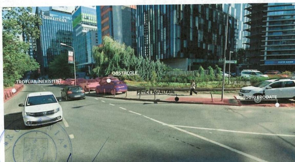
Figură 59 - Imagini reprezentative cu starea tehnică a trotuarului de pe strada Gara Herăstrău
