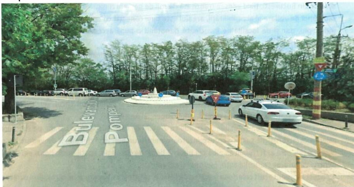
Figură 90 - Zona intersecție dintre Bld. Dimitrie Pompeiu și Soseaua Petricani. Amenajată cu sens giratoriu din elemente modulare
