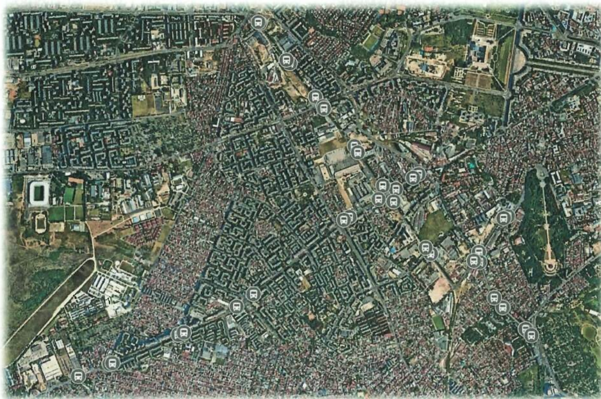
21. Zonele de intervenție a proiectului Sector 5 (Stații cu sistem de informare dinamic - e-Paper amplasat în stațiile de tramvai)
