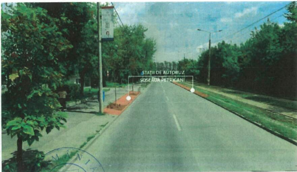
Figură 44 - Fotografie care ilustrează starea stațiilor de autobuz Șoseaua Petricani
