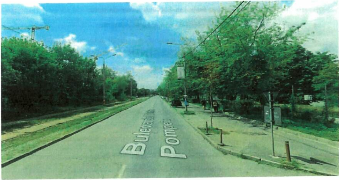
Figură 90 - Zona Bld. Dimitrie Pompeiu , cu delimitare fata de linia e tramvai, 2 benzi de circulatie, trotuare pietonale si alveole copaci
