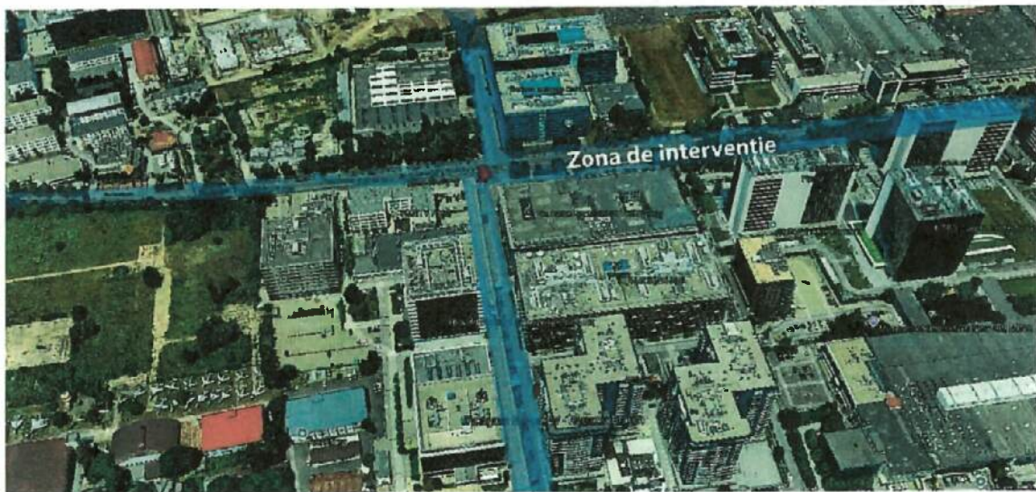
Figură 76 - Ilustrare fotografică zonei de intervenție între b-dul Dimitrie Pompeiu și Șoseaua Fabrica de Glucoză,
