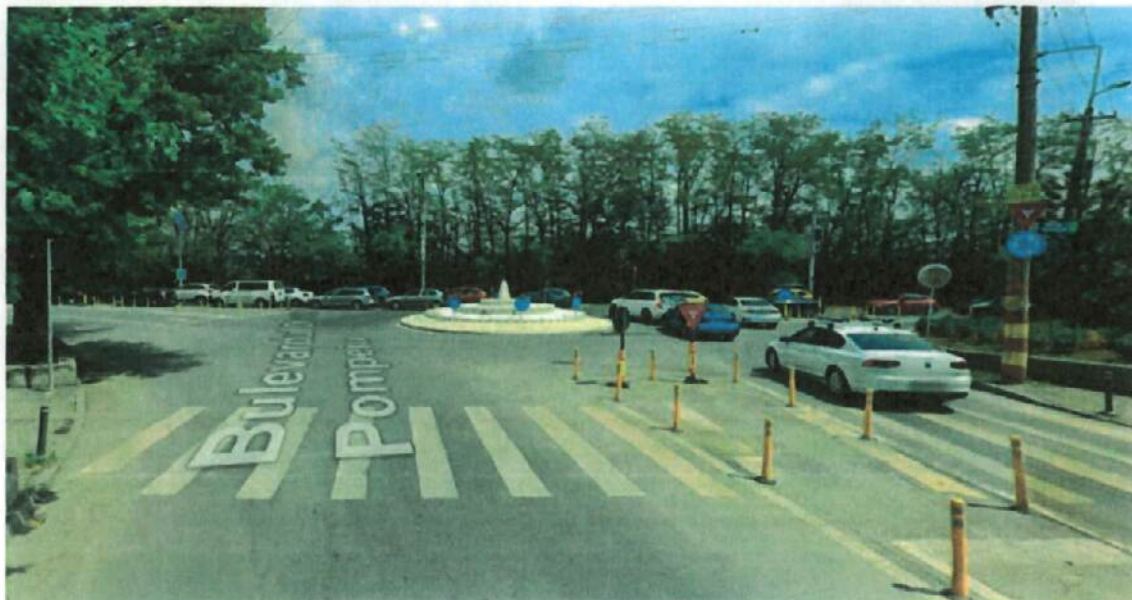
Figură 89 - Zona intersecție dintre Bd. Dimitrie Pompeiu și Soseaua Petricani. Amenajată cu sens giratoriu din elemente modulare
