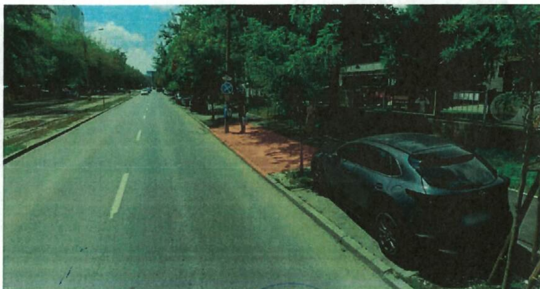
Figură 46 - Fotografie care ilustrează starea stației de autobuz Rocin spre Strada Gara Herăstrău
