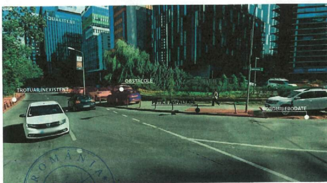
Figură 58 - Imagini reprezentative cu starea tehnică a trotuarului de pe strada Gara Herăstrău
